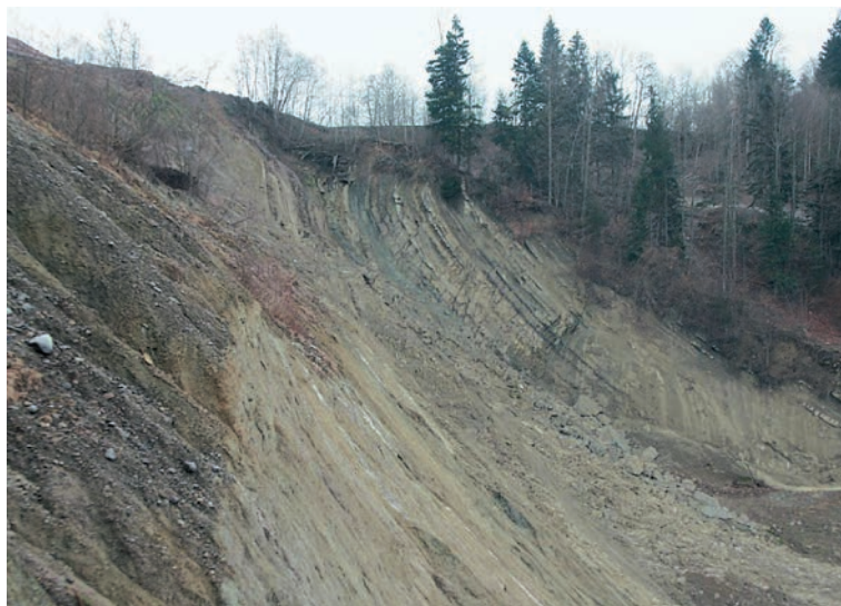
Fig. 4: Abbruchwand in den Weißsachschiechten mit hangparallelem Schichtfallen (Foto: W. JARITZ). Crack face at Weißsach layers with slope parallel bedding (photograph: W. JARITZ).
